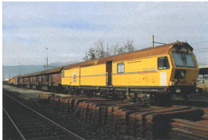
Train meuleur de rails (Scheuchzer S.A.)
