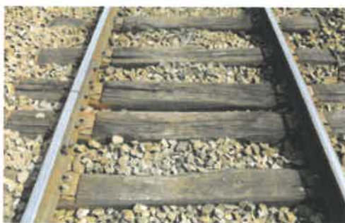
Rails courts sur traverses bois
